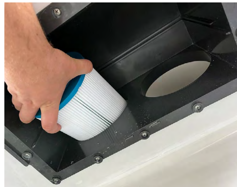
Bild 4: Einsetzen der Filter
